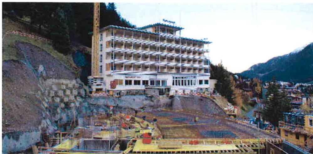
Unter den beim «Esplanade» neu erstellten drei Stockwerken befindet sich die bisher grösste Erdsondenheizung in Davos.
